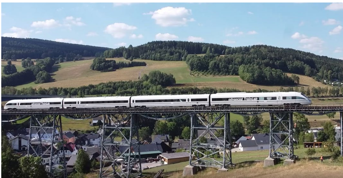
Bild 1: Markersbacher Viadukt mit dem advanced TrainLab, dem Labor- und Testzug der DB
